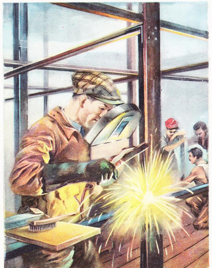
Un autre pas sur la route du progrès a été marqué par la maison à charpente entièrement métallique. Ce genre d'armature permet d'économiser l'espace et la main-d'oeuvre, et se prête à des réalisations plus rapides. Les poutrelles d'acier, préparées à l'extérieur du chantier, sont soulevées par des grues puissantes qui les posent les unes au-dessus des autres. Des ouvriers spécialisés se chargent de les souder entre elles rapidement.
